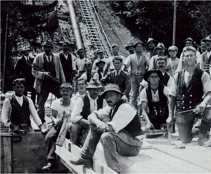
Rückblick – Arbeiter auf der Baustelle beim Gampadelswerk (1924).
